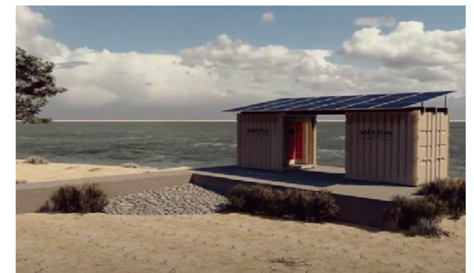
Container-basierte Mini-Grid-Anlage mit Batterieladesevice und Trinkwasseraufbereitung.
